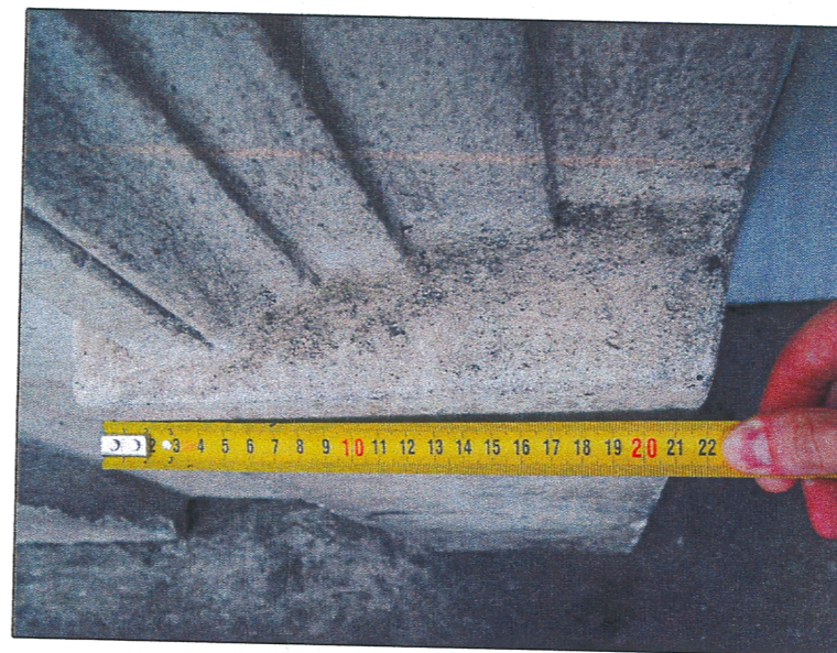
obramienie drzwi wejściowych
