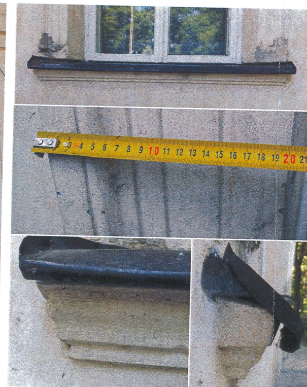
detal obramienia okiennego prostego i gzymsu podokiennego
