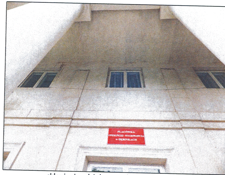
sklepienie odcinkowe, pilastry i gzyms międzypiętrowy
