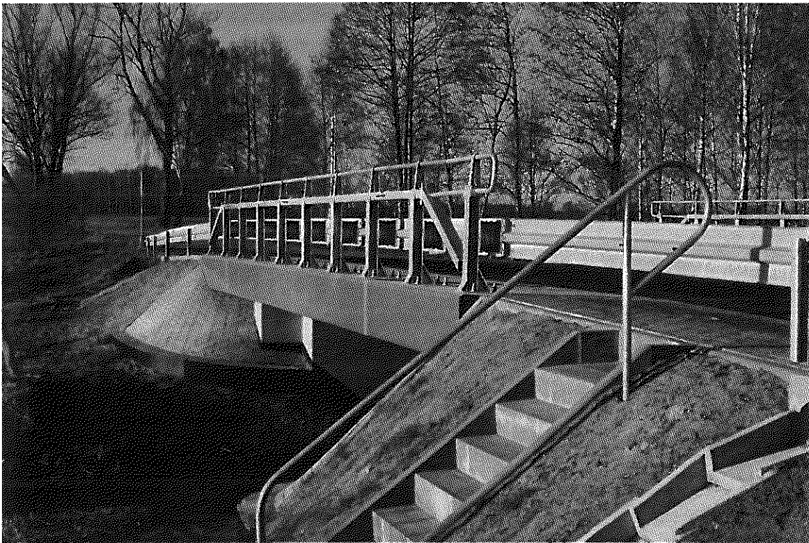
Most na rzece Tuchetka w Dudowiznie po przebudowie
