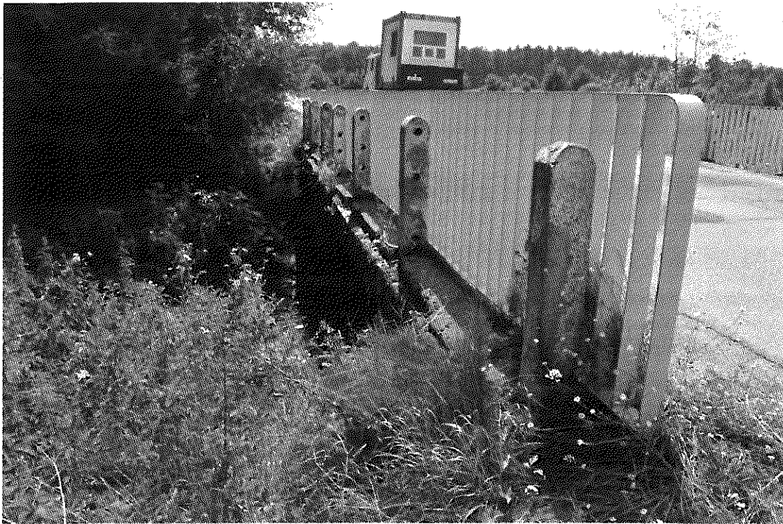
Most na rzece Tuchetka w Dudowiznie przed przebudową
