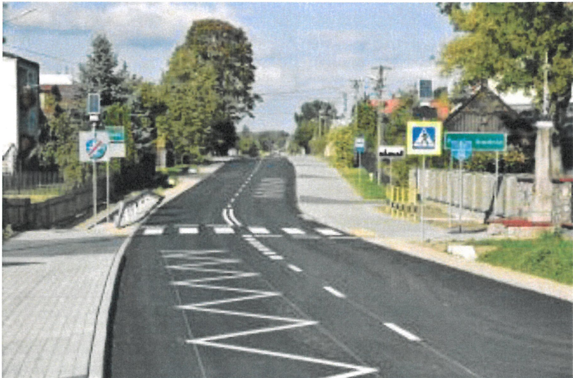
Droga powiatowa nr 4405W na odcinku Poręba Średnia – Udrzynek po przebudowie
