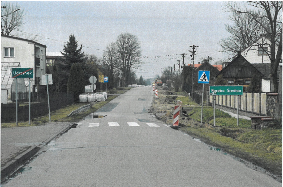
Droga powiatowa nr 4405W na odcinku Poręba Średnia – Udrzynek przed przebudową
