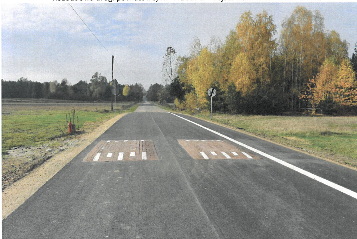
Progi zwalniające typu wyspowego na przebudowanej drodze powiatowej nr 4402W na odcinku Nowa Pecyna – Długosiodło
