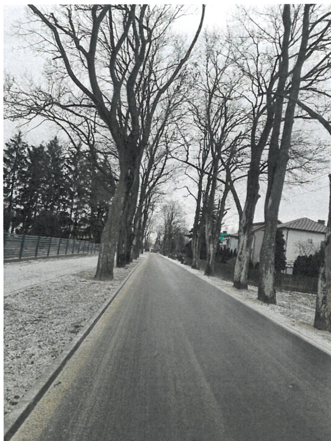
Rozbudowa drogi powiatowej Nr 4410W w miejscowości Somianka-Parcele
