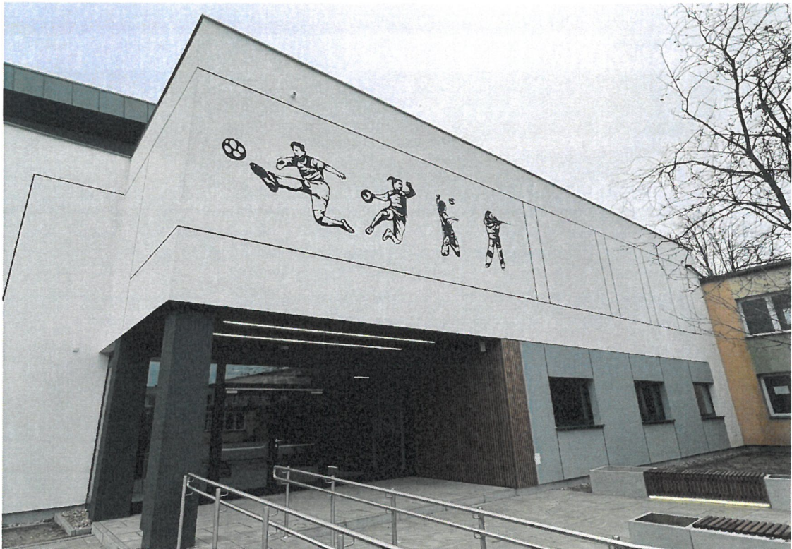
Hala sportowa przy Centrum Edukacji Zawodowej i Ustawicznej „Kopernik” w Wyszki – wejście główne
