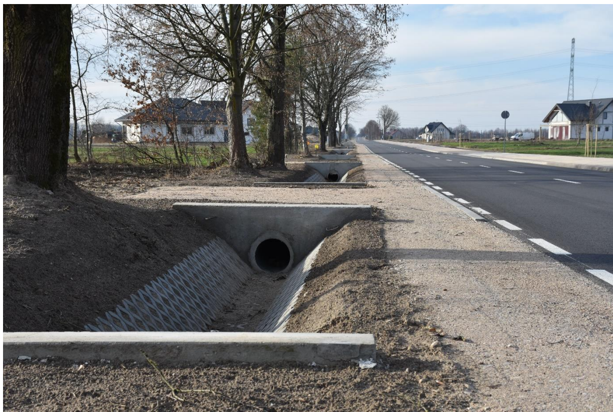
Rozbudowa drogi powiatowej Nr 4403W na odcinku od granicy z Gminą Wyszków do ul. Kamienieckiej w m. Brańszczyk – Etap I
