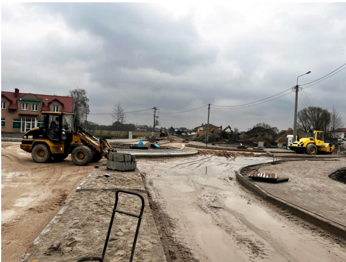
Budowa drogi powiatowej Nr 1811W od skrzyżowania z drogą powiatową Nr 4421W w miejscowości Zabrodzie, do skrzyżowania z drogami gminnymi w miejscowości Adelin wraz z rozbiórką i budową infrastruktury technicznej
