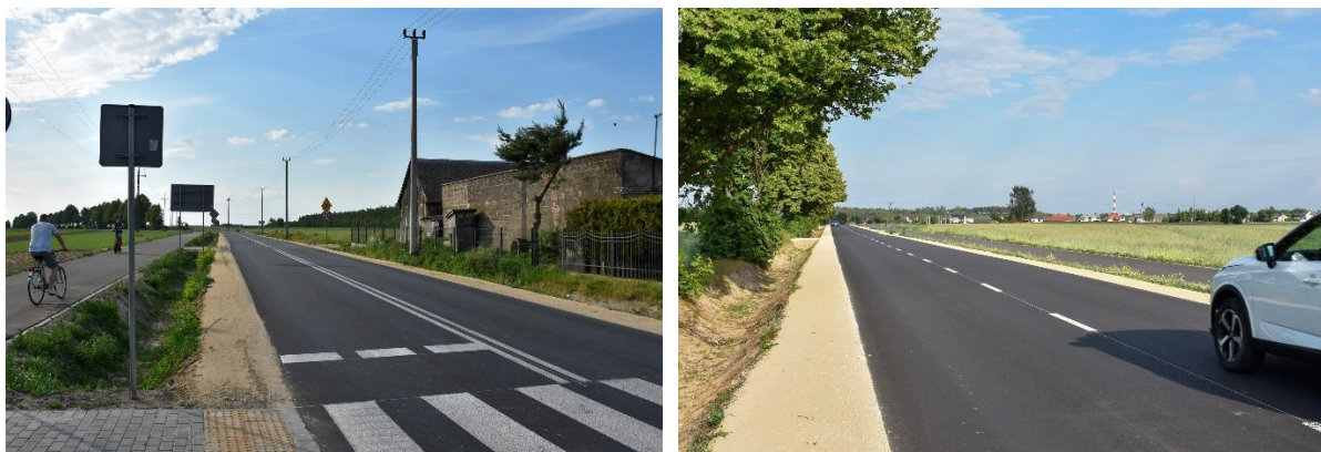
Budowa drogi powiatowej Nr 4415W Leszczydół Stary - Leszczydół Działki
