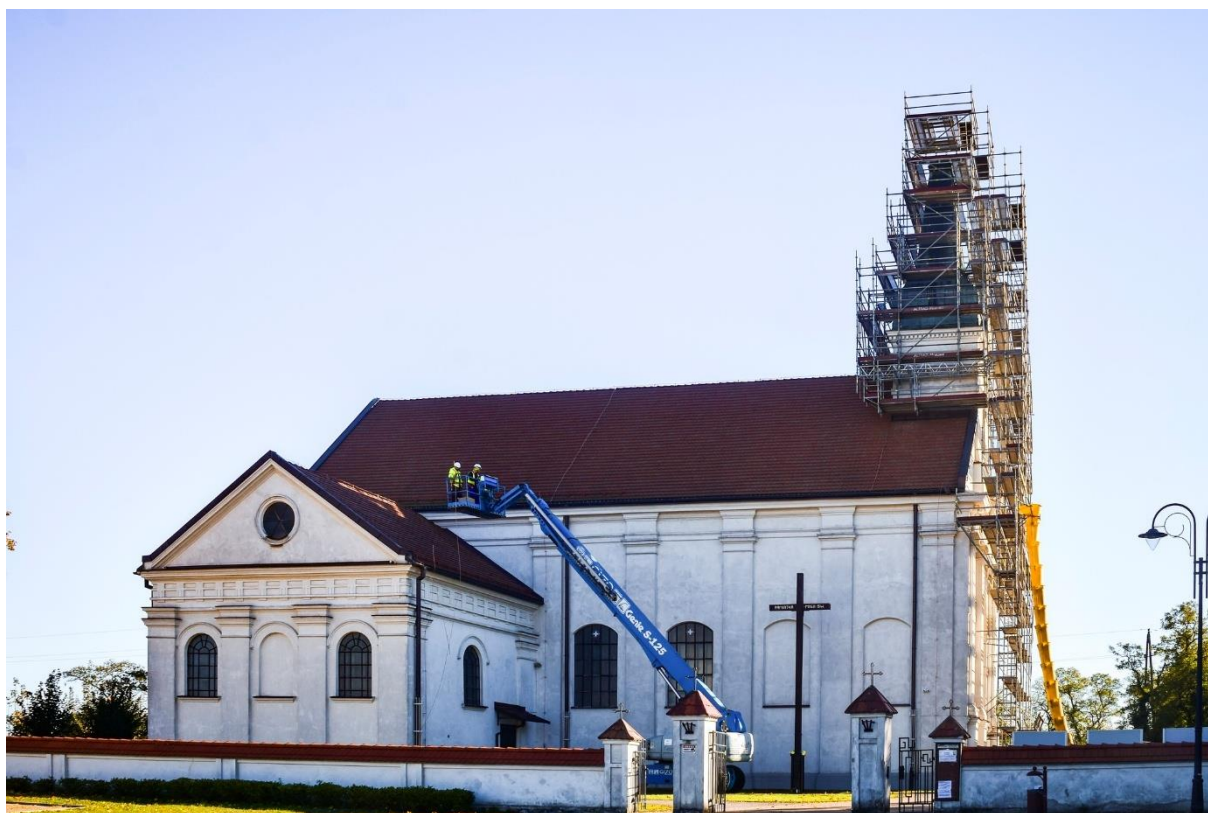
Sanktuarium św. Idziego w Wyszkanie - remont dachu na wieży kościelnej, instalacja odgromowa
