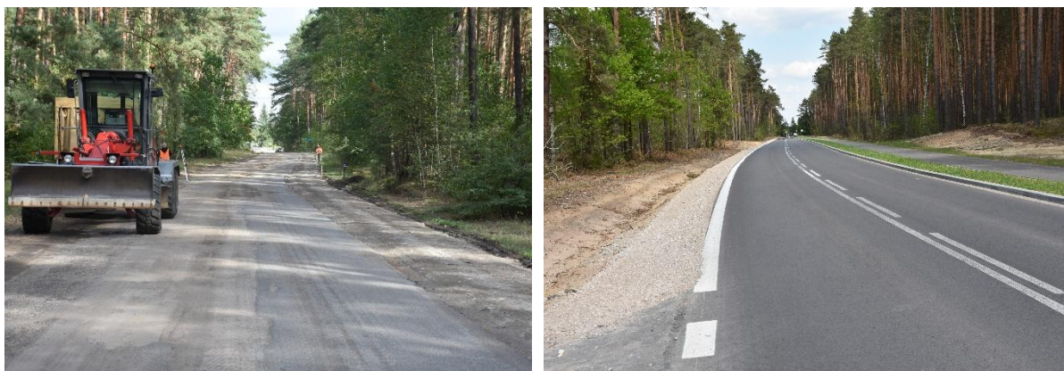
Budowa DP Nr 4408W na odcinku Długosiodło – Przetycz Włościańska – Etap I
