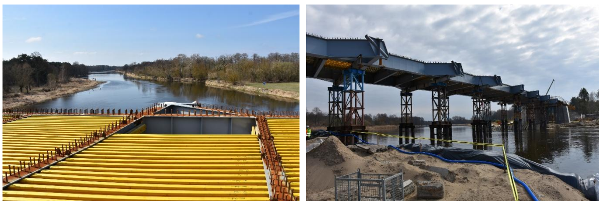
Budowa mostu przez rzekę Narew, łączącego gminy Rzęśnik i Rzewnie
