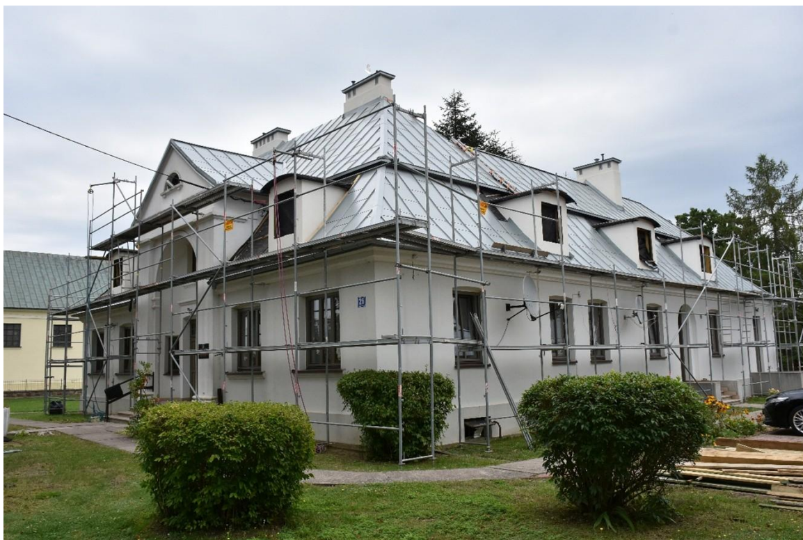
Prace konserwatorskie polegające na wymianie więźby dachowej wraz pokryciem dachu budynku plebanii w Brańszczyku
