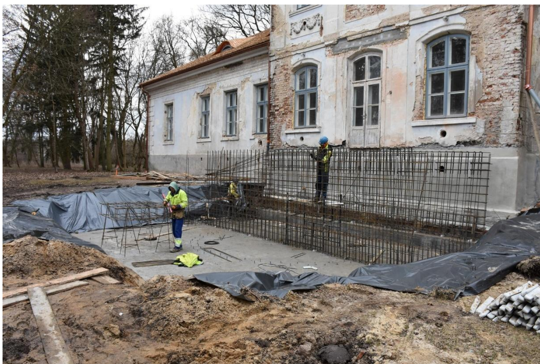
Prace konserwatorskie w Muzeum Cypriana Norwida w Dębinkach (w organizacji) - w trakcie budowy nowej konstrukcji tarasu
