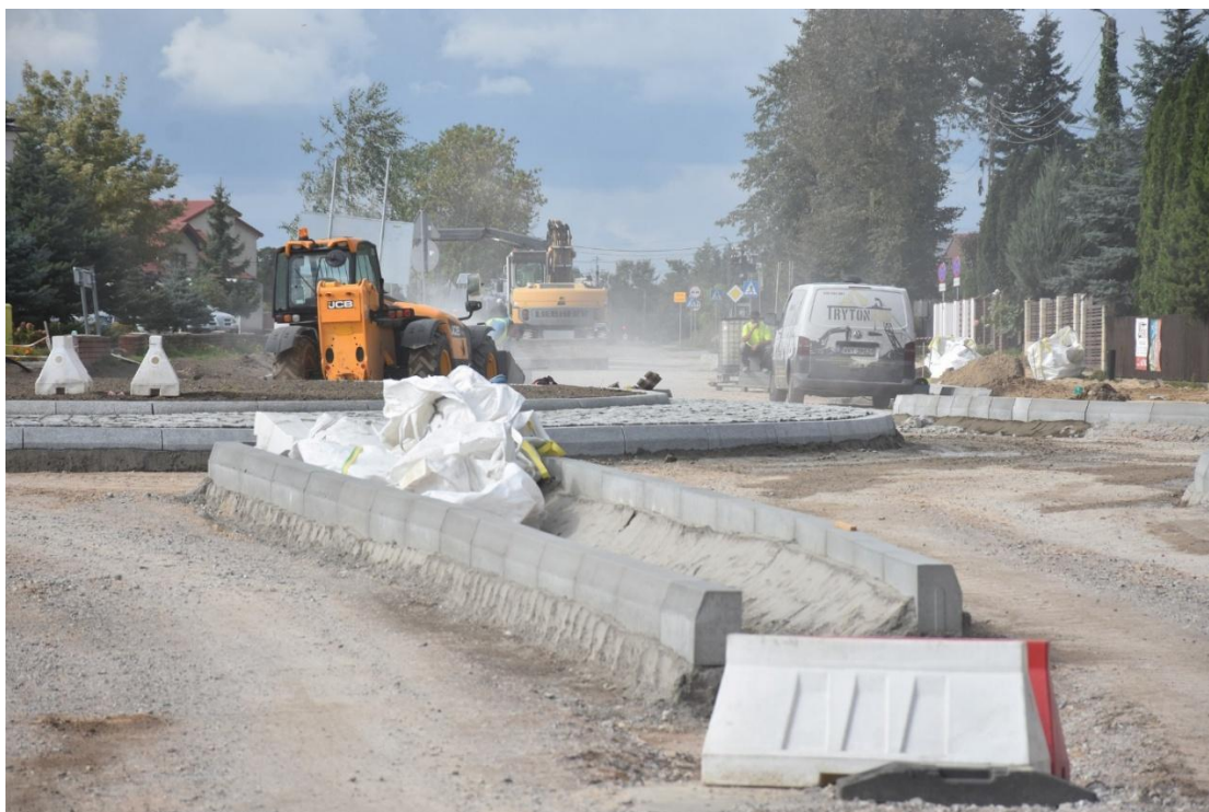
Budowa DP Nr 4407W na odcinku Porządzie – Rzęśnik – granica powiatu – Etap II
