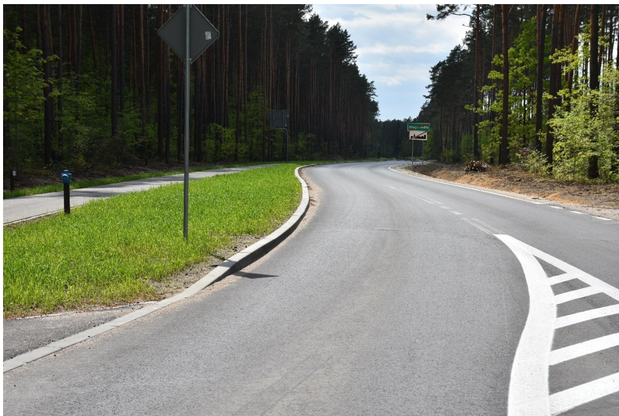
Budowa DP Nr 4408W na odcinku Długosiodło – Przetycz Włościańska – Etap I
