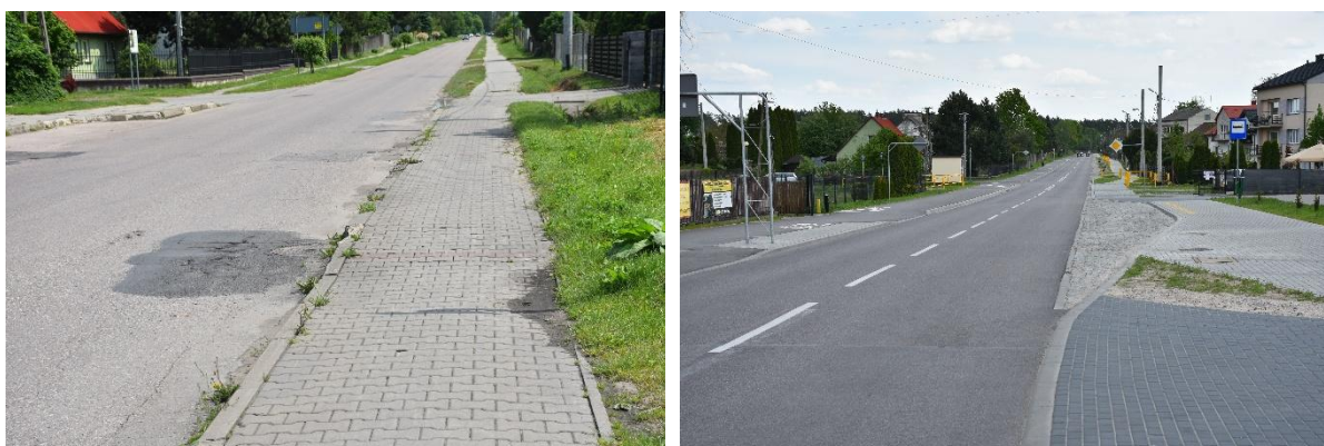
Budowa DP Nr 4407W na odcinku Porządzie – Rzęśnik – granica powiatu – Etap II
